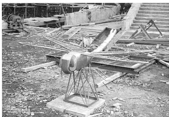
図9 本館頂上に設置された蜻蛉
